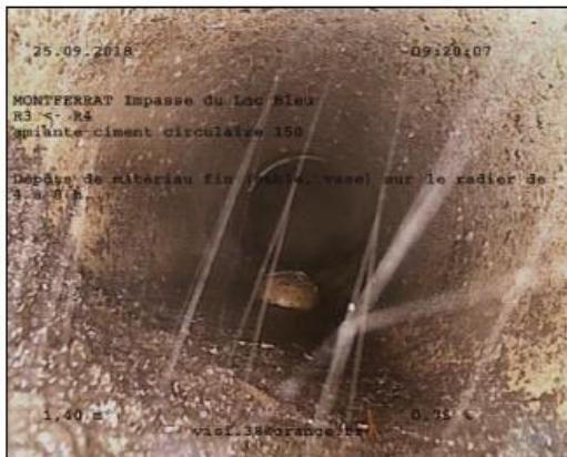
Photo: 4_2A 1,4m, Dépôts de matériau fin (sable, vase) sur le radier de 4 à 8 h. -
