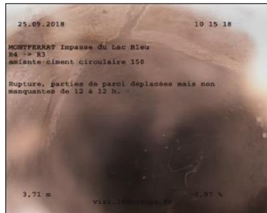
Photo: 8_2B 3,61m, Rupture, parties de paroi déplacées mais non manquantes de 12 à 12 h. -
