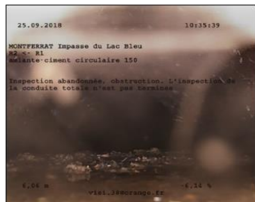
Photo: 9_5A 6,06m, Inspection abandonnée, obstruction. L'inspection de la conduite totale n'est pas terminée
