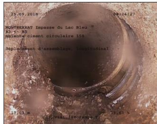
Photo: 5_3A 17,07m, Déplacement d'assemblage, longitudinal - -
