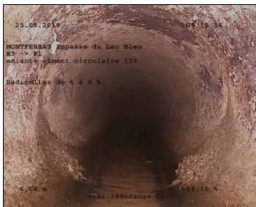
Photo: 3_4A 6,58m, Radicelles de 4 à 8 h. -
