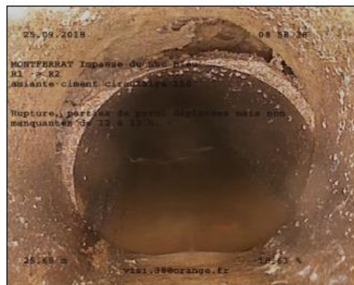
Photo: 1_5A 25,69m, Rupture, parties de paroi déplacées mais non manquantes de 12 à 13 h. -
