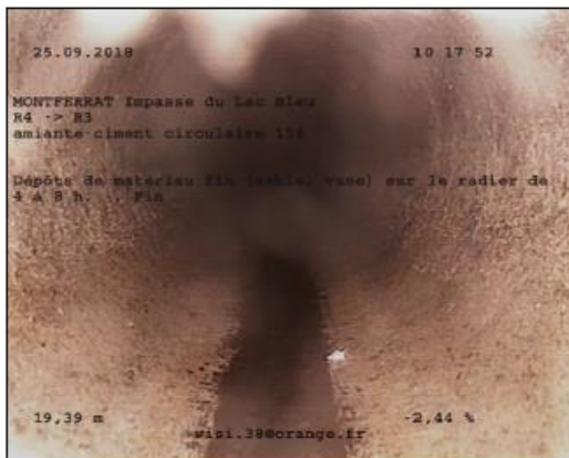
Photo: 8_5A 19,39m, Dépôts de matériau fin (sable, vase) sur le radier de 4 à 8 h. -, Fin
