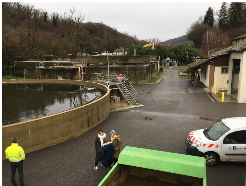
La station d'épuration de Charavines
