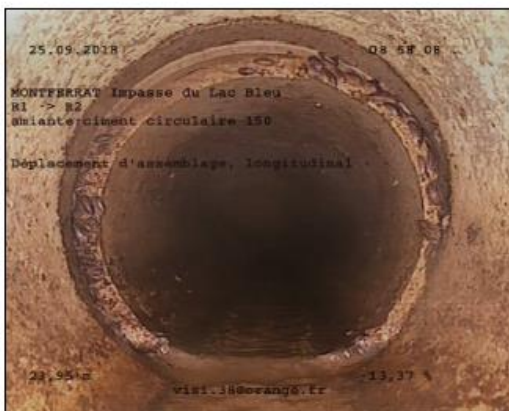
Photo: 1_4A 23,95m, Déplacement d'assemblage, longitudinal --
