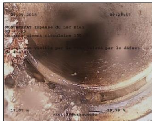
Photo: 5_5A 17,07m, Le sol est visible par le trou laissé par le défaut de 4 à 8 h.
