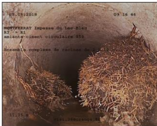
Photo: 3_6A 11,36m, Ensemble complexe de racines de 2 à 10 h. -
