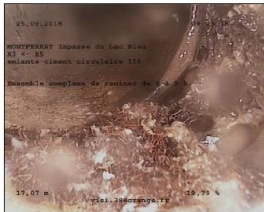
Photo: 5_6A 17,07m, Ensemble complexe de racines de 6 à 9 h. -
