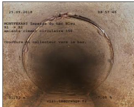
Photo: 1_3A 21,52m, Courbure du collecteur vers le bas, -
